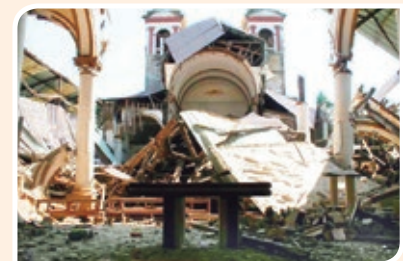
▲ Iglesia de Los Salesianos en Linares tras el terremoto.
