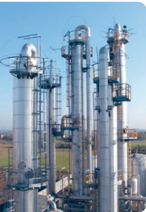
▲ Torre de fraccionamiento.
